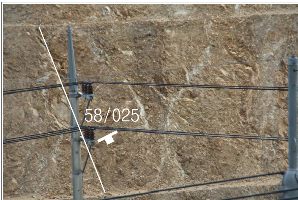
【그림 29】 B 영역에 발달한 불연속면
