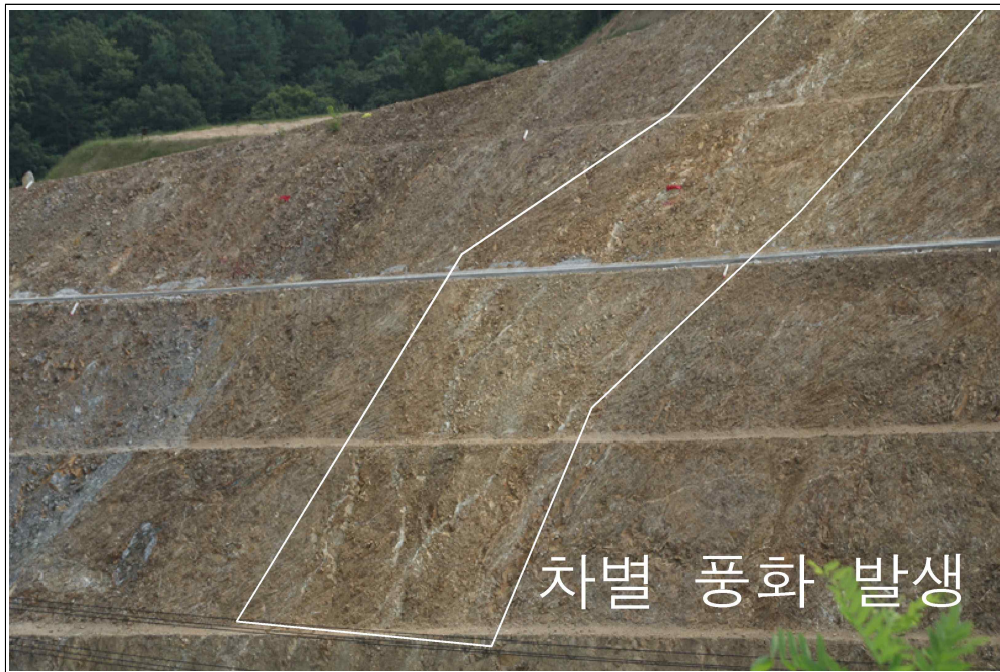
【그림 34】 B 영역 상세사진 (차별 풍화 발생)
