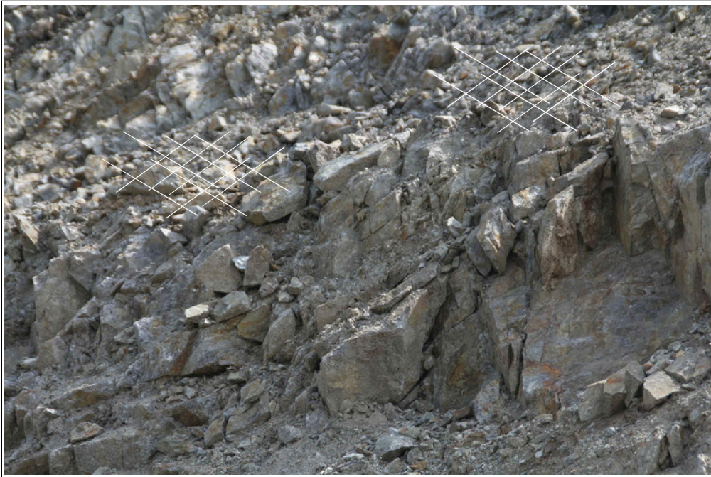
【그림 18】 A 영역 상세사진 (세편화된 암석)
