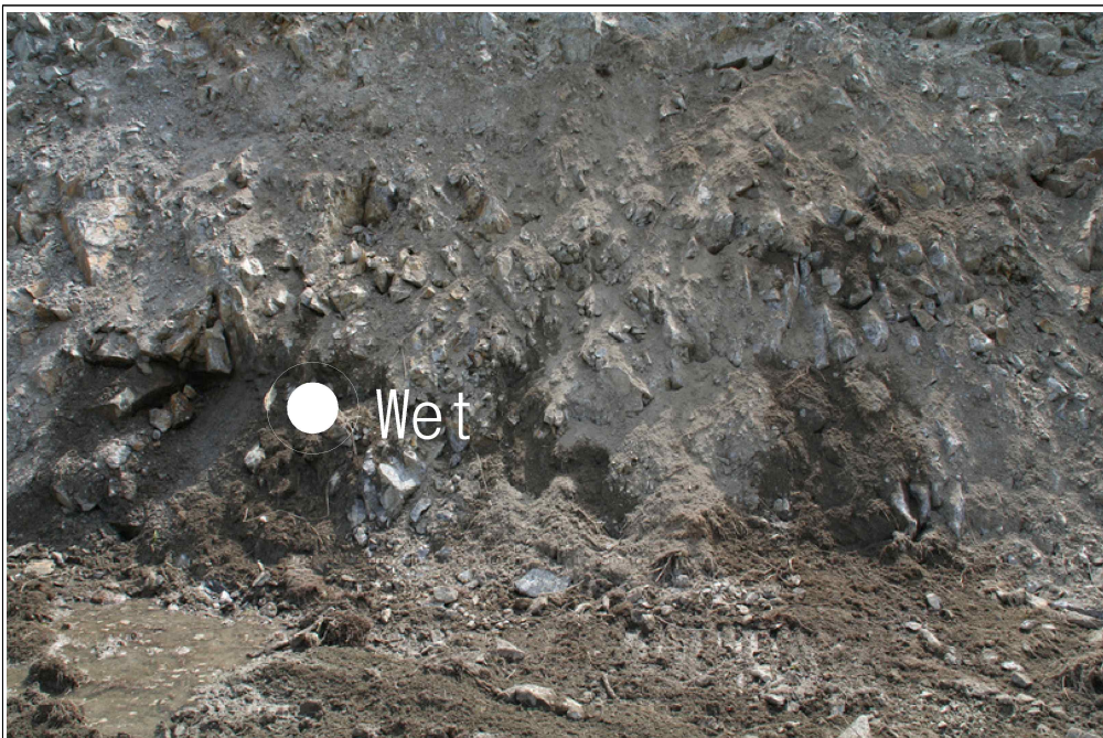
【그림 19】 A 영역 상세사진 (지하수 유출)
