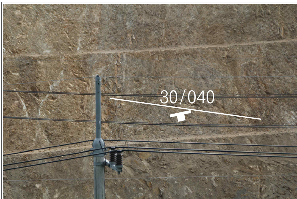
【그림 27】 B 영역에 발달한 불연속면
