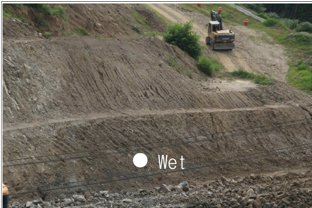
【그림 49】 D 영역 상세사진 (지하수 유출)
