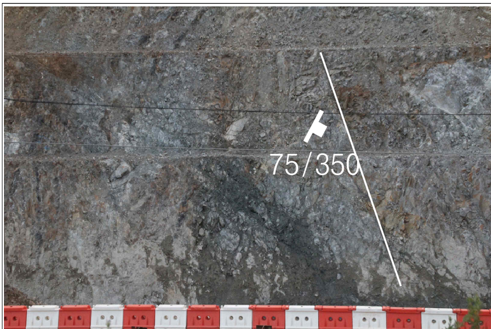
【그림 15】 A 영역에 발달한 불연속면
