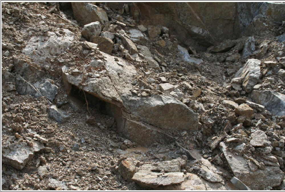
【그림 46】 D 영역 상세사진 (이완된 암편)
