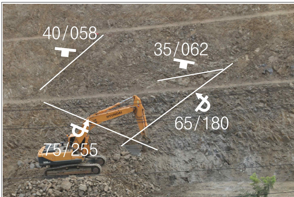
【그림 36】 C 영역에 발달한 불연속면
