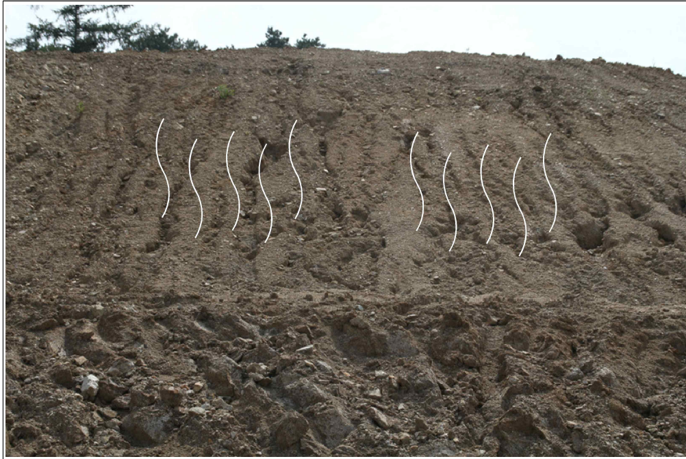
【그림 48】 D 영역 상세사진 (토사유실 및 우류침식)
