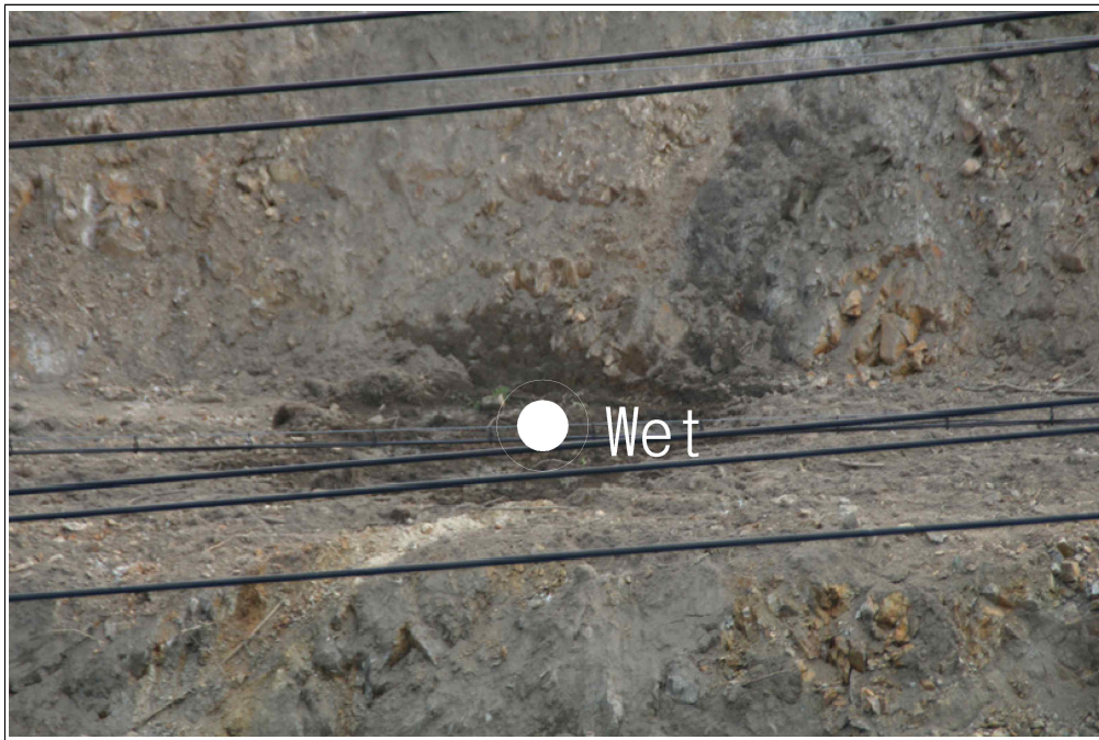
【그림 20】 A 영역 상세사진 (지하수 유출)
