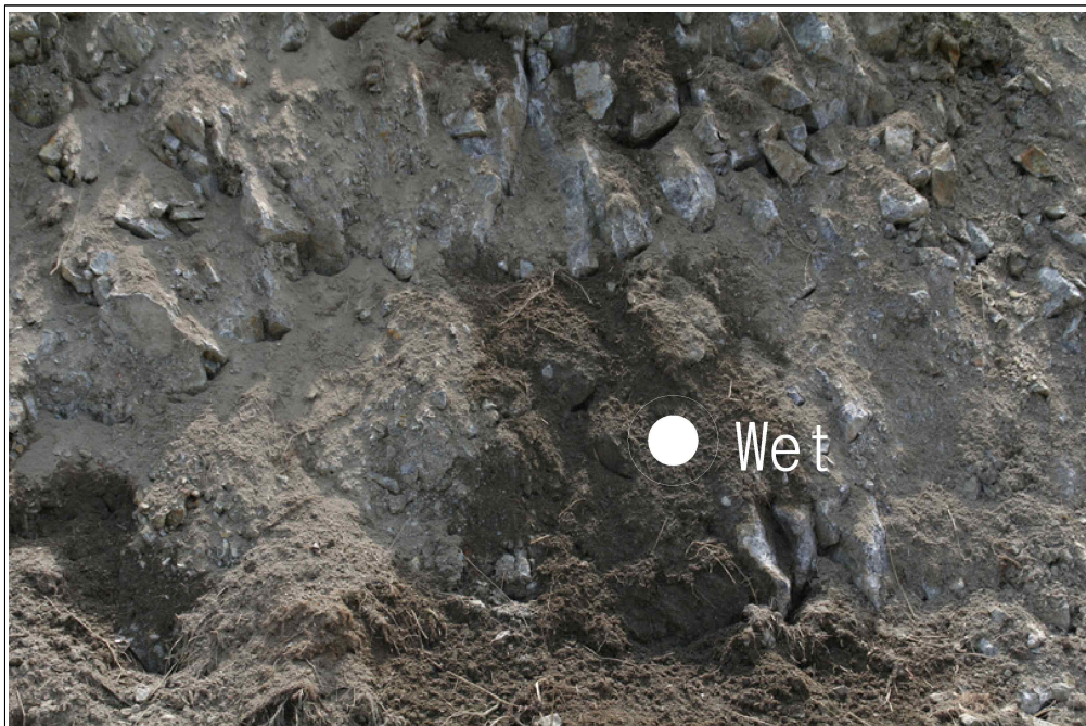
【그림 21】 A 영역 상세사진 (지하수 유출)
