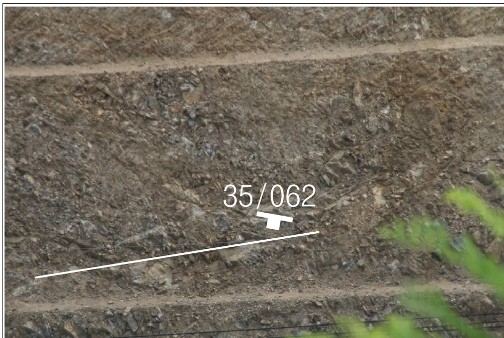
【그림 38】 C 영역에 발달한 불연속면
