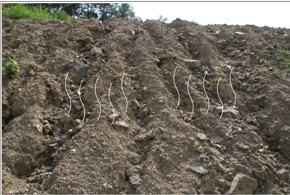
【그림 47】 D 영역 상세사진 (토사유실 및 우류침식)
