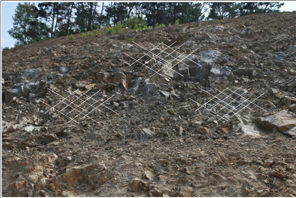
【그림 44】 D 영역 상세사진 (세편화된 암석)
